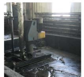
下图：中国某大型洗煤厂中使用的沃曼立式泵
