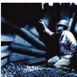
Esquerda: Inspeção do revestimento de borracha Vulco.
