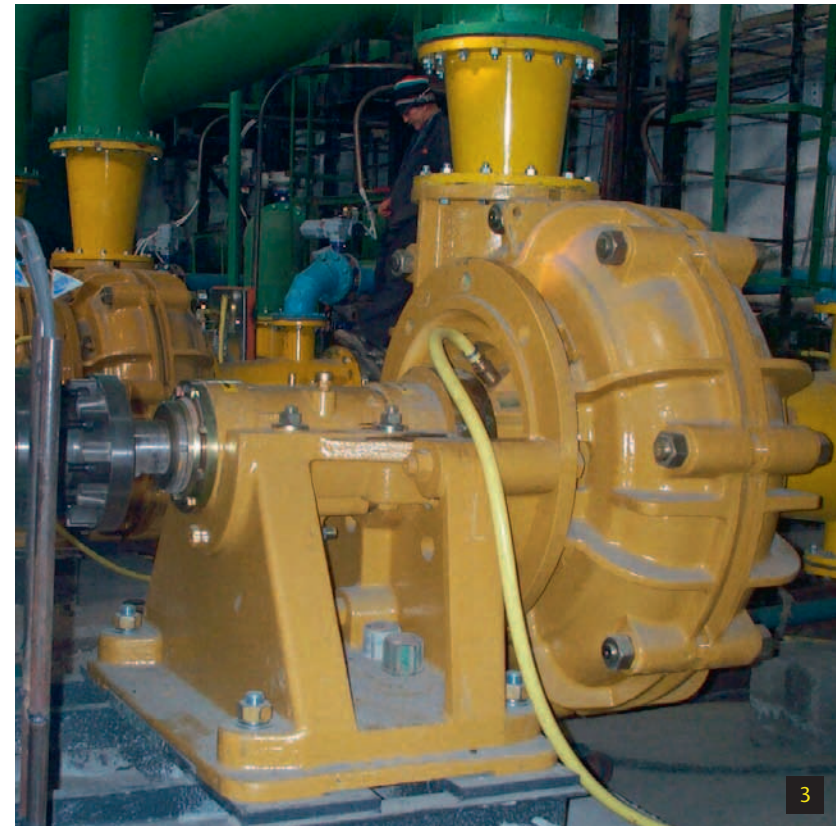
3 : 3 pompes 10/8 FFYAH en service dans une mine
