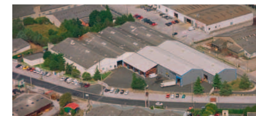
Usine de Castres (81)
