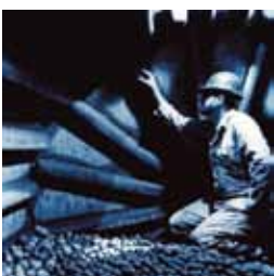
Esquerda: Inspeção do revestimento de borracha Vulco.
