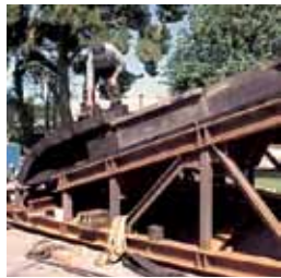
Acima: Exemplo de pré-montagem do conjunto de descarga (descarregadores de polpa) para moinhos AG/SAG.
