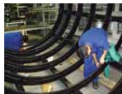
Acima: Proteção Antiabrasiva com revestimento de borracha aplicado na estrutura metálica.
