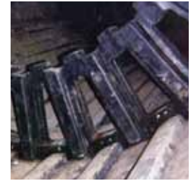
Acima: Revestimento de Borracha (região periférica).
