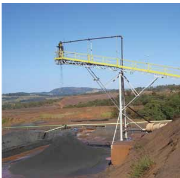
Minério de Ferro - Empilhamento do produto
