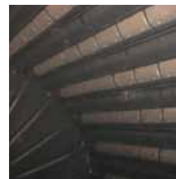
Revestimento com caps metálicos no cilindro.
