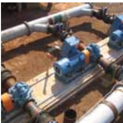
Bombas bipartidas em estação fixa de abastecimento de água.
