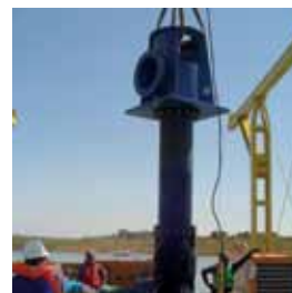
Abaixo: Montagem Balsa de Captação
