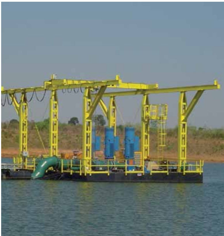
À esquerda: Balsa de Captação Água Recuperada
